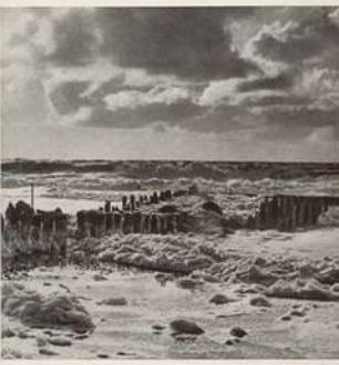
**Buhnen** sind feste Wälle meistens aus Holz, Beton- oder Eisenpfählen, oft mit schweren Steinen oder Faschinen (Buschwerk) verstärkt und viele Meter vom Land ins Meer hinausgebaut. Sie schützen als Wellenbrecher das Ufer oder dienen zur Neulandgewinnung.
